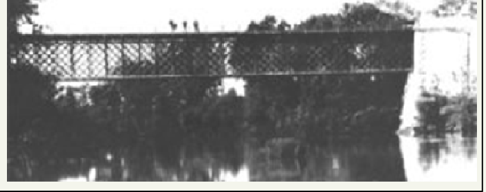
San Giorgio a Liri. Il ponte in ferro sul Liri "in servizio" dal 1876 al 1944 (Archivio C. Jadecola).
